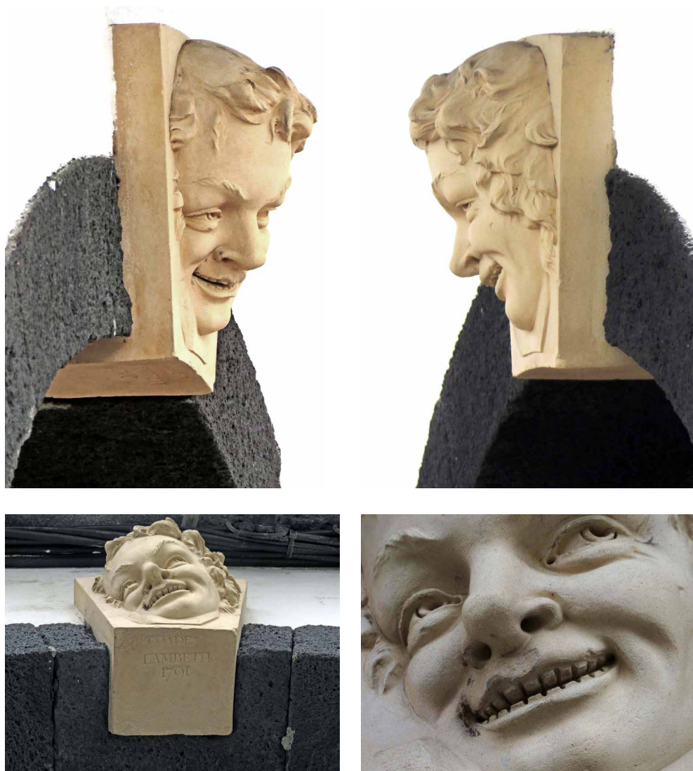
FIGURA 30 • Rua Teófilo Braga: detalhes da pedra-chave representado um sátiro e marcada “Coade / Lambeth / 1791” (fotos do autor). De notar que estas peças geralmente não tinham função estrutural. Com base em fotografias de exemplares hoje musealizados ou colocados à venda em leiloeiras de antiguidades, o tardo destas keystones apresenta dois ocos, facilitando o encaixe na estrutura arquitectónica.
