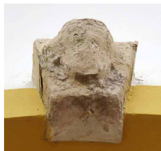
FIGURAS 39, 39A e 38B · Palácio Fonte Bela: três pedras-chave dos vãos do piso superior, a última das quais já quase irreconhecível, devido ao seu mau estado (fotos do autor).
