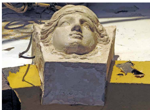
FIGURAS 38 e 38A · Palácio Fonte Bela: pedra-chave num vão que ladeia o de acesso à escadaria, tal como estava há cerca de dez anos e com os danos com que surgiu depois da obra de "limpeza" e pintura da parede (fotos do autor).
